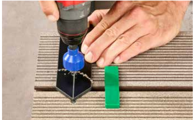
1. Positionner le gabarit au centre de la SP et marquer les points de perçage
