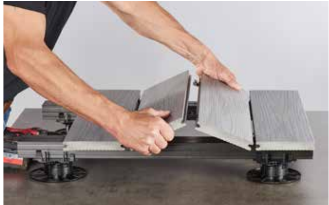
1. Monter les clips de montage latéralement
