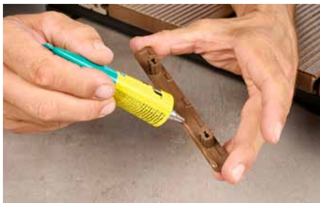
1. Appliquer de la colle sur le bord supérieur
